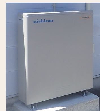
家庭用蓄電池(16.6kWh)
