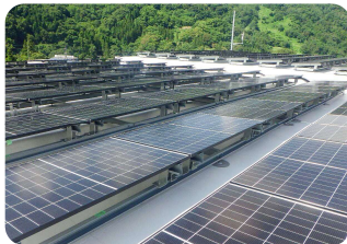
▲ PPA太陽光パネル設置工事 電気自立で村を守る
